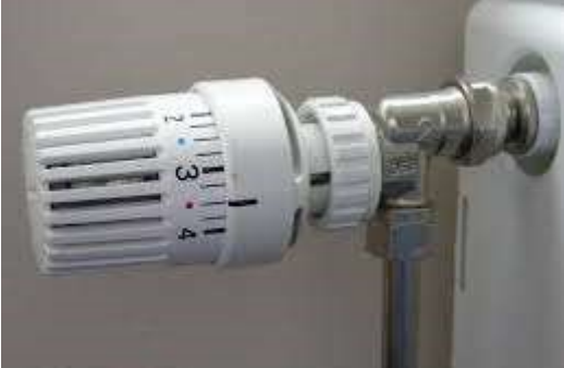
㉞ 판형 방열기 상부 입구에 설치한 예 (수평 설치)
