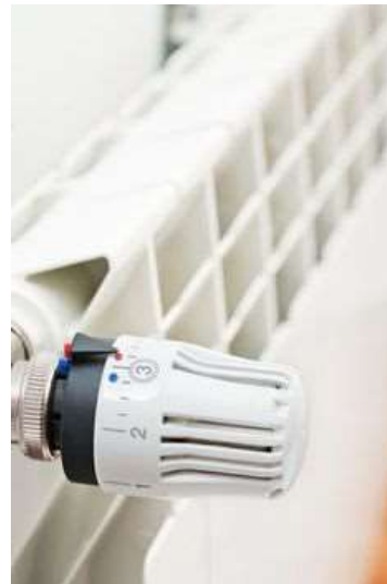
㊷ 주물형 방열기 하부 공급관에 설치한 예 (수평 설치)
