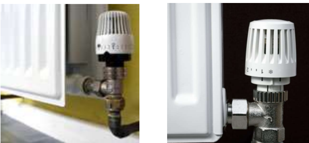
㊲ 판형 방열기 하부 공급관에 설치한 예 (수직 설치)
