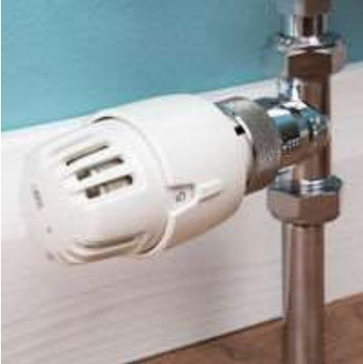
㊲ 판형 방열기 하부 공급관에 설치한 예 (수직 설치)
