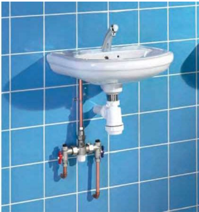
㉥ 냉 온수 동시 공급 설치 한 예 (수직 설치)
